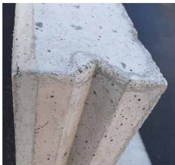
Elementene fra Mysen leveres med not-not
