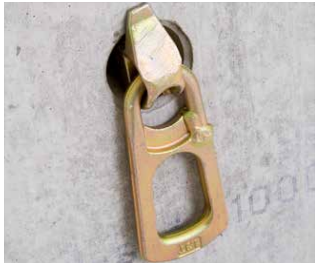
Ankerhode for løft av L-element
